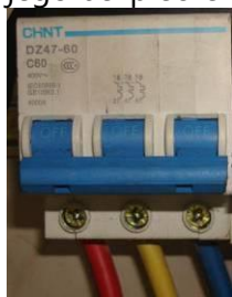
Rysunek 9 Przykładowe zabezpieczenie nadprądowe
